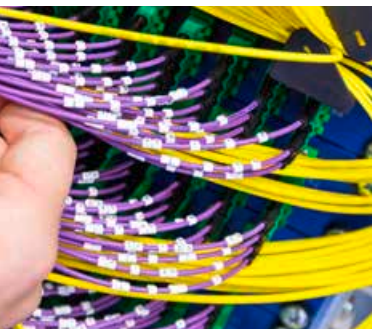
links: Backbone-Fasern zur Signalübertragung zwischen den POPs // rechts: Glasfaserverbindungen für jeden einzelnen Kunden im POP
