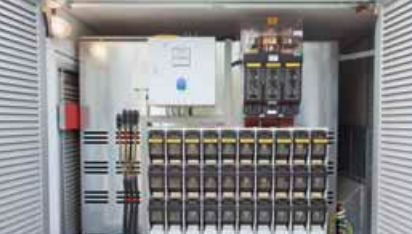
Links: Eine Mittelspannungsschaltanlage // Mitte: Im Ahornweg // Rechts: Niederspannungsverteilung in einer Trafostation.
